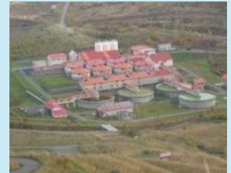
（坑廃水処理施設の例）
