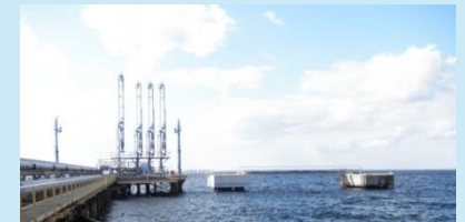
※ 製品出荷棧橋の土台
