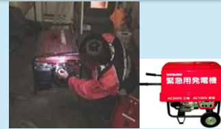
・自家発電機の導入
