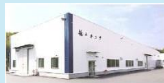
倒壊した工場・施設等の復旧支援
